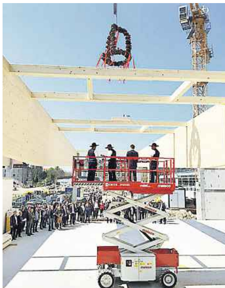
Über den Dachbindern des künftigen Rewe-Marktes wurde gestern ein Richtkranz hochgezogen. Foto: Jens Rometsch
