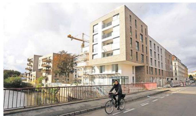
Neben der Brücke in der Industriestraße sind jetzt die Baugerüste für ein Wohn- und Geschäftshaus gefallen. Foto: André Kempner
