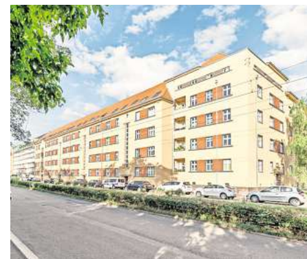
Kategorie Bauen im Bestand: Einen im Krieg zerstörten Flügel vom Gohlis Carré hat Instone Real Estate wieder aufgebaut.
