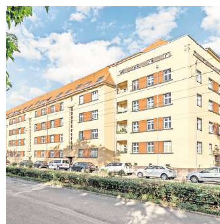
Kategorie Bauen im Bestand: Hier gewann die Firma Instone mit dem soeben pünktlich fertiggestellten Gohlis-Carré.
